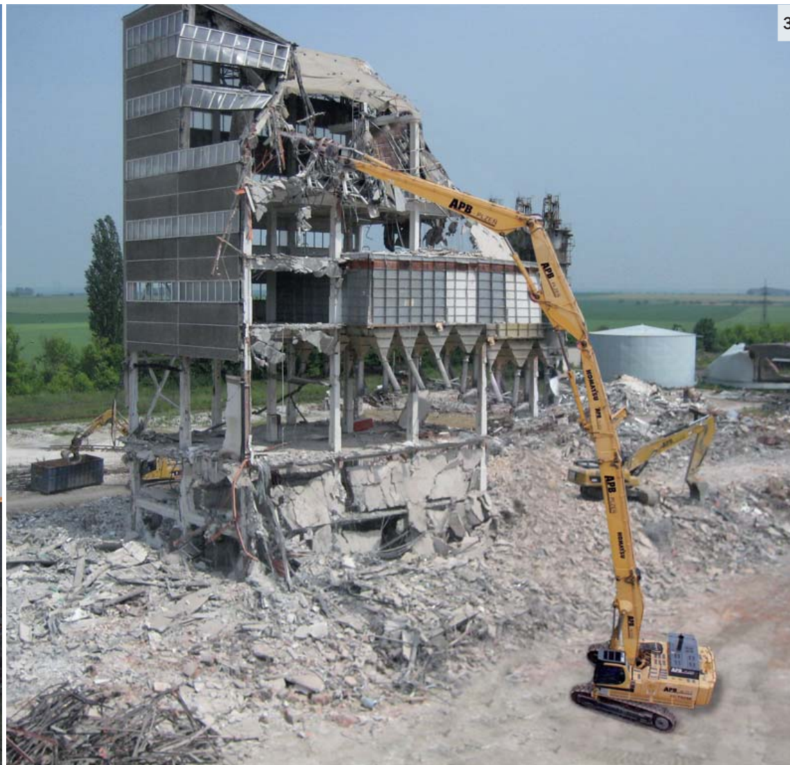
[1] - demolice objektu zauhlování dolu v Karviné
