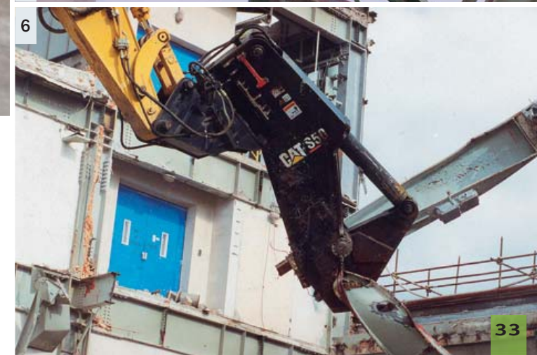
[4], [5], [6] - pohled na stříhání ocelových nosníků hydraulickými nůžkami
