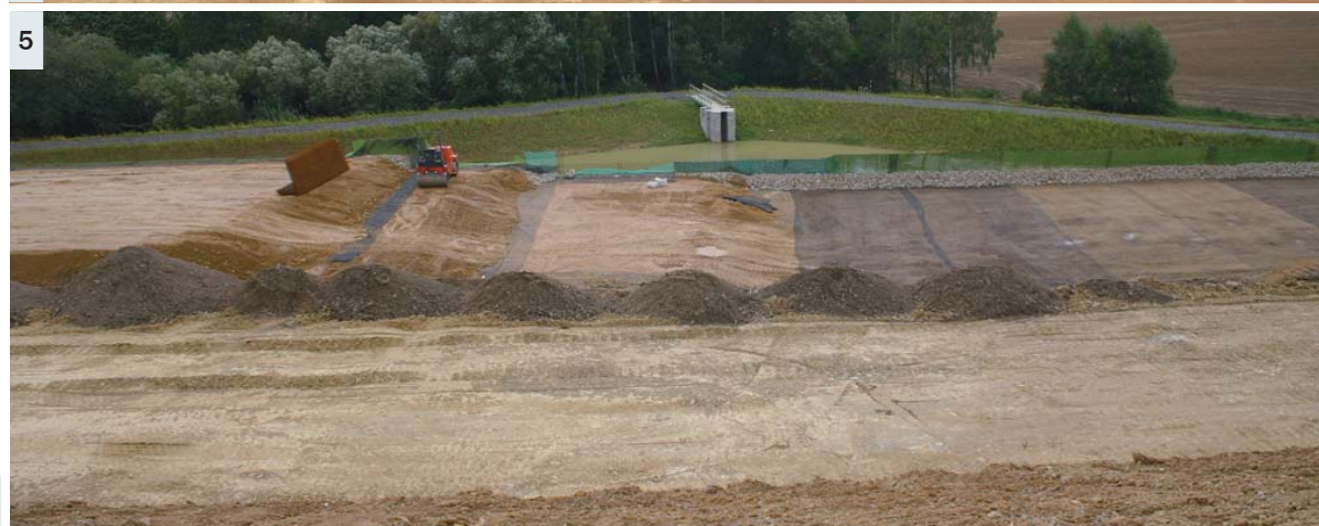
[4], [5], [6] - provedení speciálního vyztuženého násypu pomocí geomříží a armovaných sítí v délce cca 2 km a maximální výšky 13,5 m. Svah této výšky a délky provedený touto metodou je jediný v ČR
