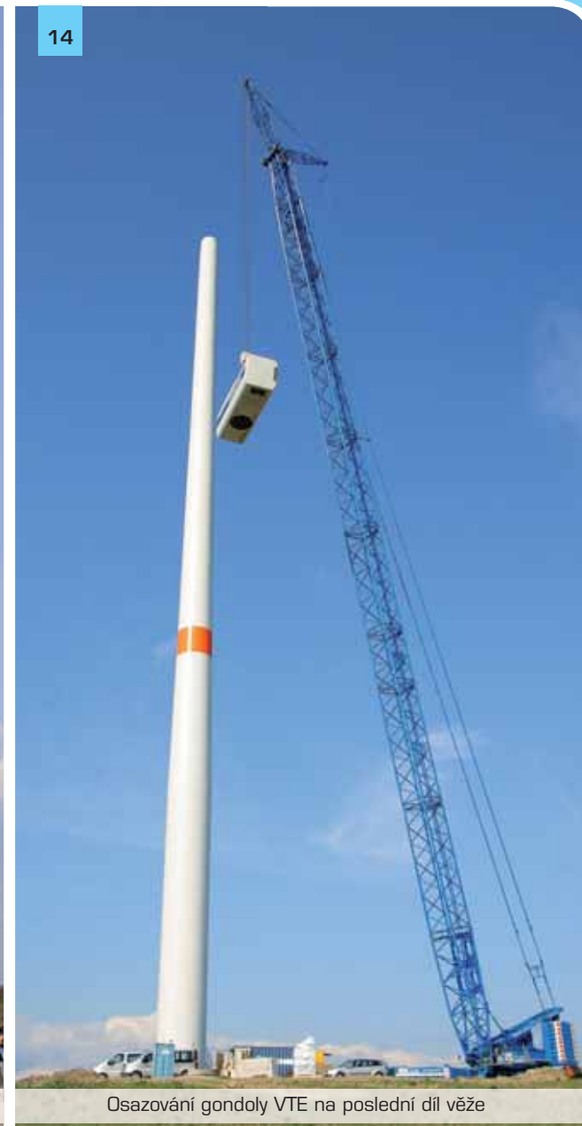
Montáž věže VTE z ocelových segmentů – poslední díl
