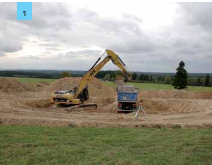
Příprava terénu pro stavbu základové desky
