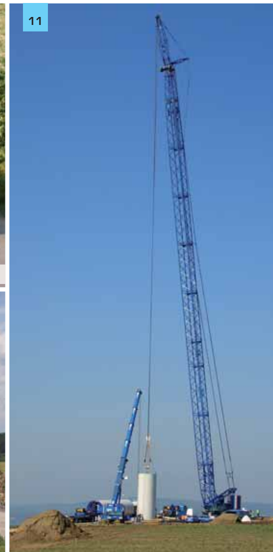
Ustavování spodního segmentu věže VTE
