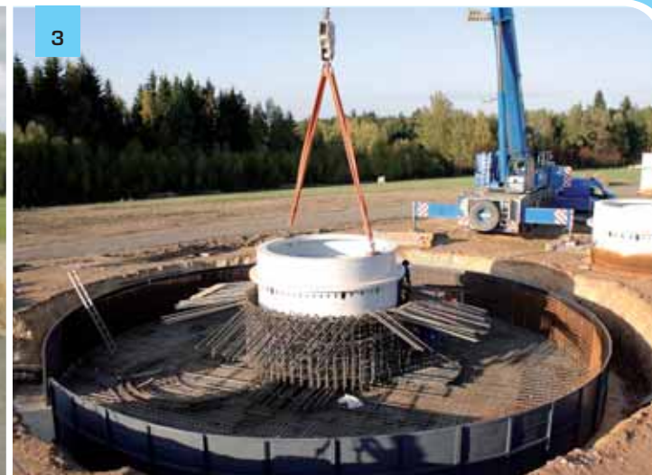
Usazování kotevního prstence věže do střední oblasti výztuže
