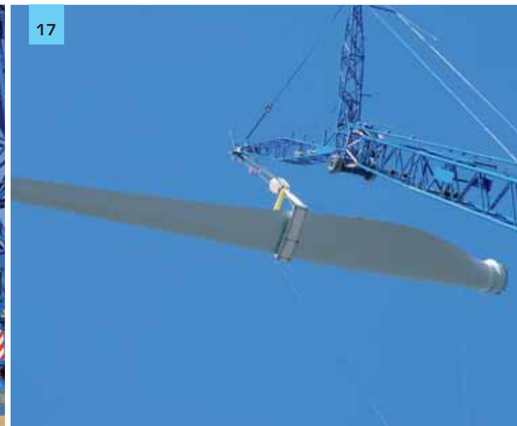
15 - 20 Montáž rotoru turbíny VTE
