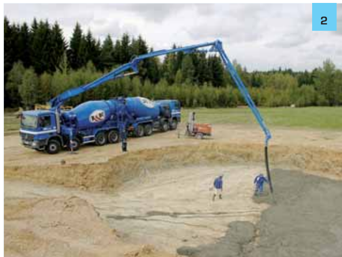
Betonování podkladní vrstvy základové desky
